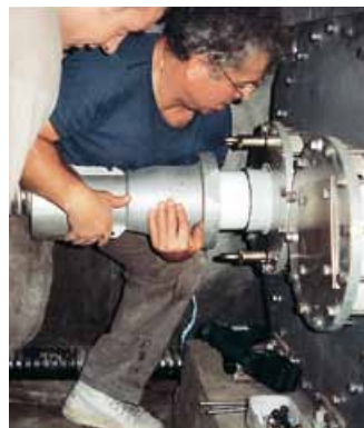
PFISTERER-Experten für HV-Kabelanlagen
