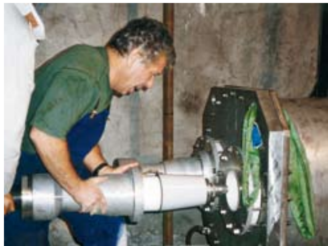
Bild 15: Stecken des HV-CONNEX-Kabelanschlussystems in T-Joint bei BPSB Xian (China)
