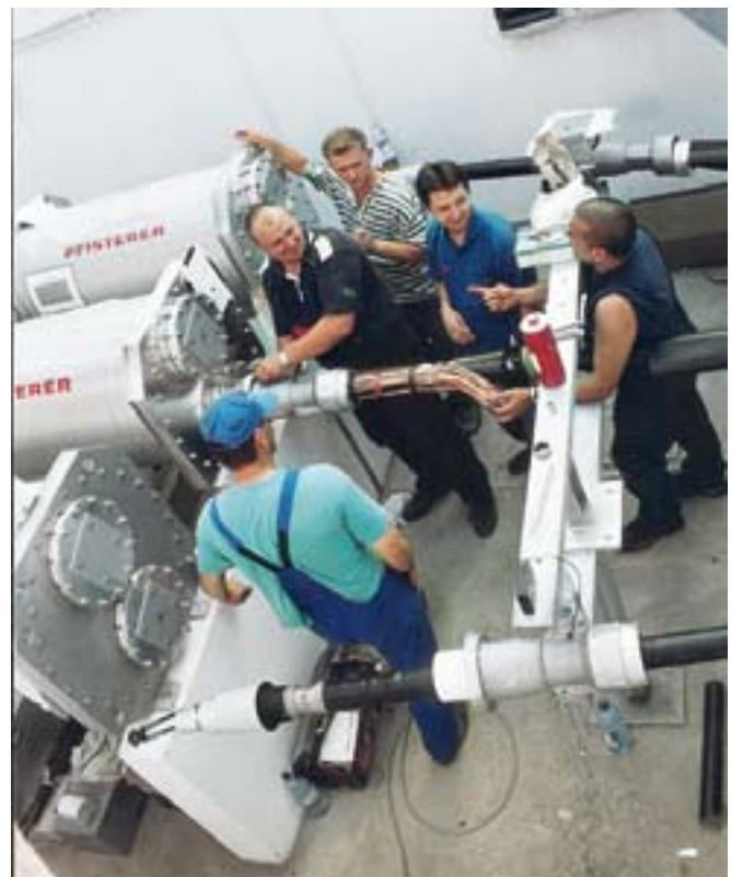
Bild 10: Kabelmontage vor dem Stecken in HV-CONNEX-T-Abzweigmuffe bei Betchatow (Polen)
