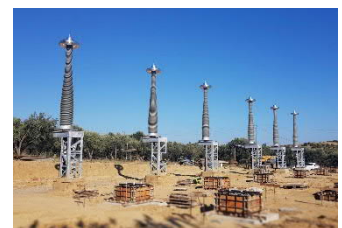
Die Montage der IXOSIL-Muffen und Freiluft-Endverschlüsse von PFISTERER zur Anbindung der neuen 400-kV-Land-Seekabel-Verbindung nahe Patras ist in vollem Gange. Ende März 2020 werden die Arbeiten abgeschlossen sein.
